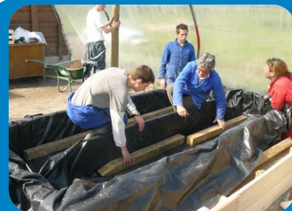
Construction des bassins de culture
