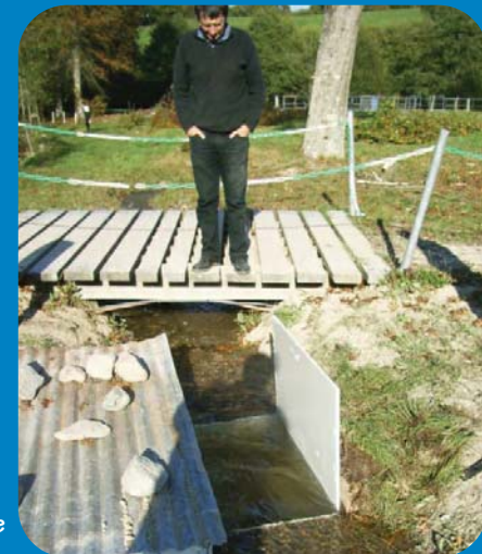
Installation de la passe à poissons et du caisson étanche pour le système de vidéo comptage
