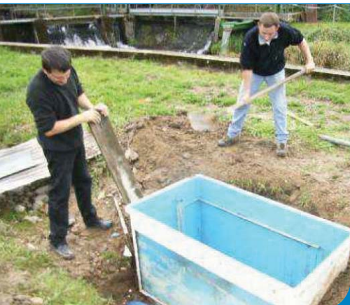
Installation de la passe à poissons et du caisson étanche pour le système de vidéo comptage
