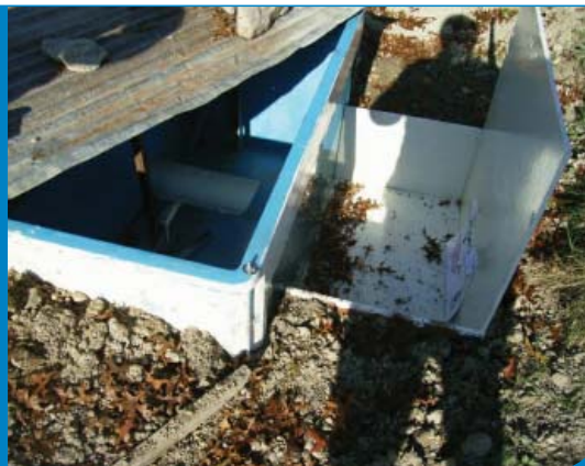
Installation de la passe à poissons et du caisson étanche pour le système de vidéo comptage
